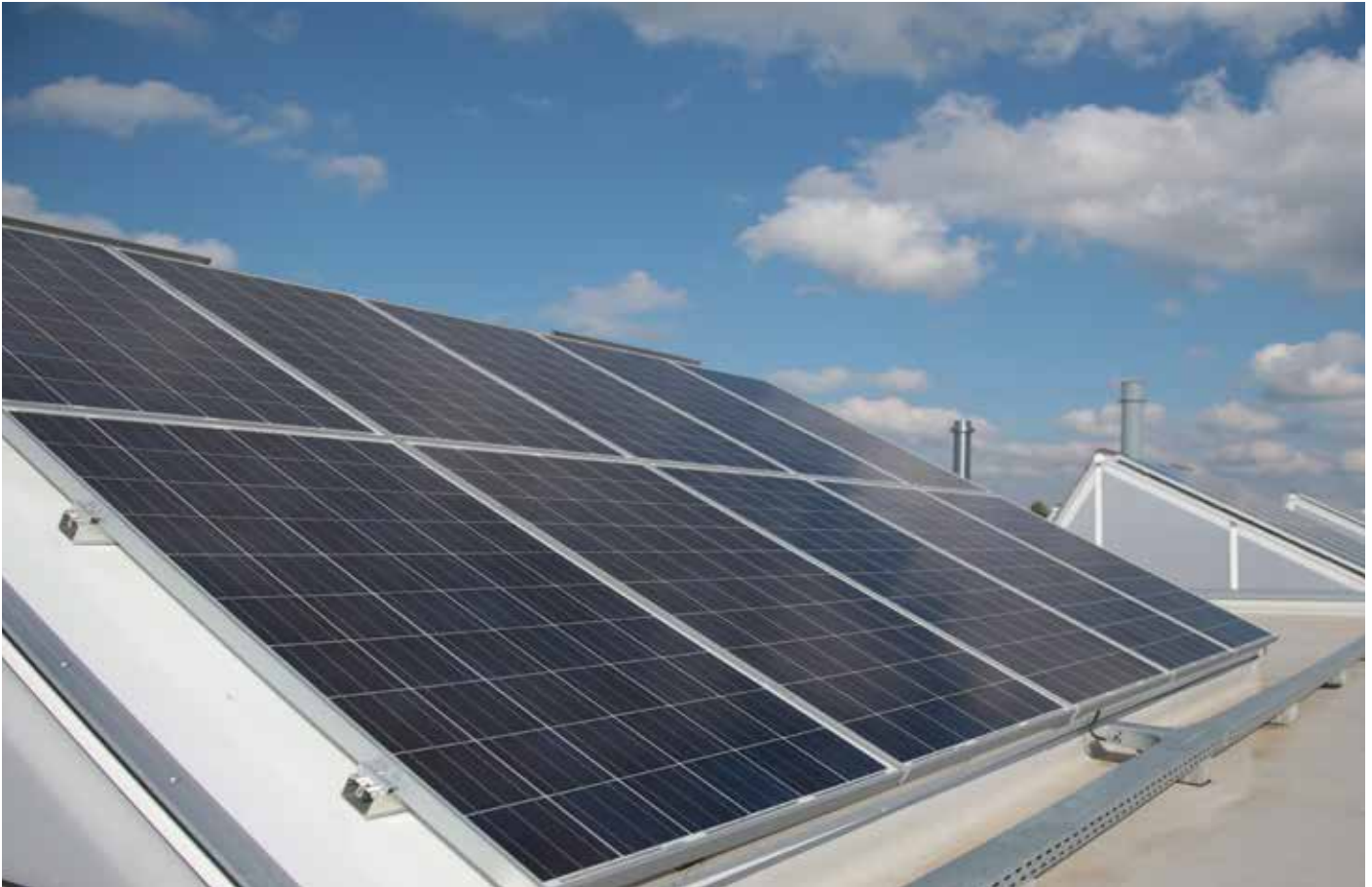
TITELMOTIV: LAMLUX PHOTOVOLTAIKANLAGE IM SHED-RÜCKEN EINES LAMLUX CI-SYSTEM LICHTBAND S
