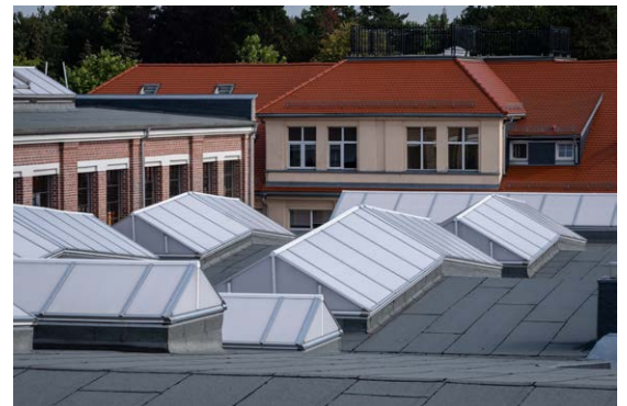
„Zündmagnet“ Wurzen – Sanierte Eventhalle
