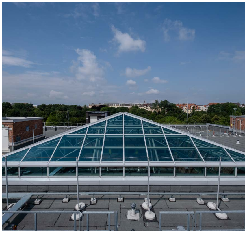
Außenansicht des LAMILUX Glasdachs PR60 auf dem Gebäude des Dante-Gymnasiums in München
