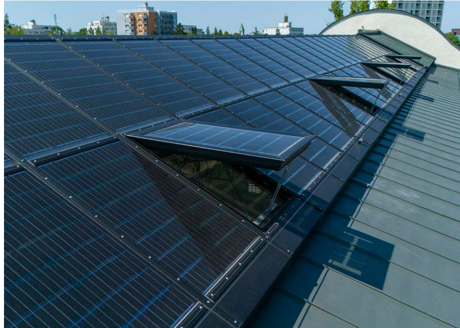
Integrierte Photovoltaik-Anlage im LAMILUX Glasdach PR60
