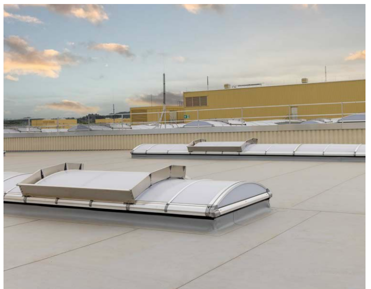
LAMILUX Lichtbänder auf dem sanieren Dach der Firma Heidel- berger Druck www.lamilux.de/lichtband
