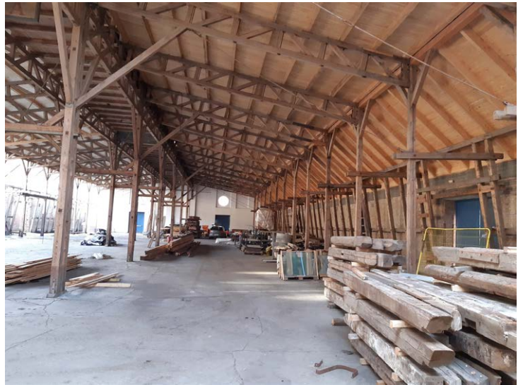
Altes, unsaniertes Lager, Havnegade 16
