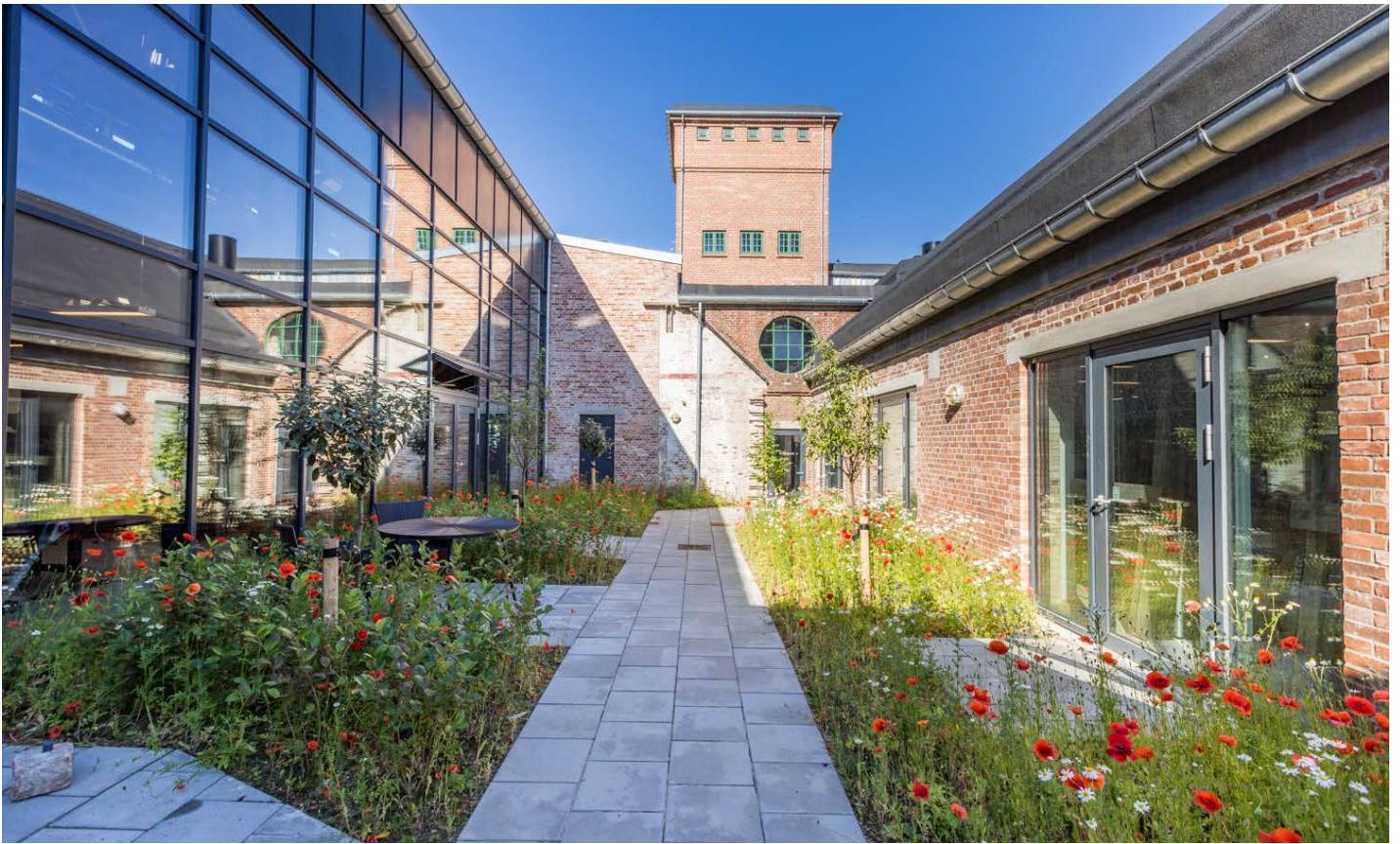
Havnegade 16 - ein Getreidelager in Dänemark aus dem Jahr 1926 wurde in Gewerbeeinheiten umgewandelt.
