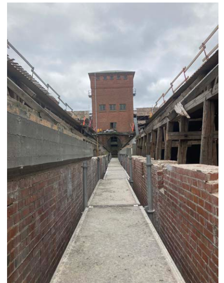
Das Getreidelager in Dänemark vor der Sanierung
