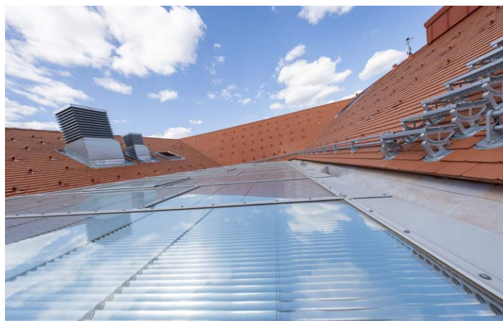
Im LAMILUX Glasdach PR60 eingebaute Spiegel sorgen für eine bewusste Brechung und Lenkung des Lichts (Referenz: Ludwig-Uhland-Schule, Nürnberg)
