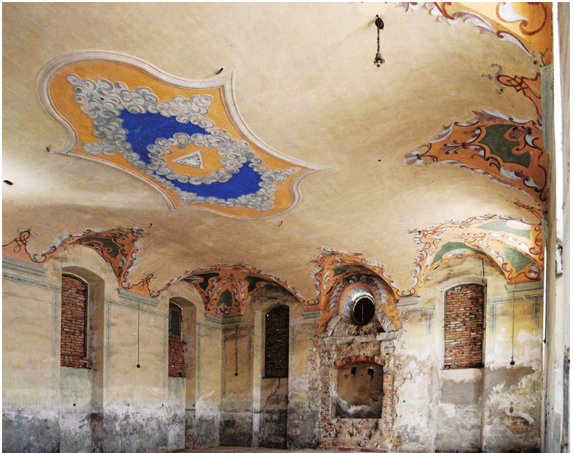
Vermutlich größte, erhaltene barocke Landsynagoge in Mühl- hausen, Bayern
