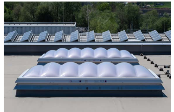
LAMILUX Lichtkuppel F100 W auf dem Industriedach der Firma Ungleht in Memmingen www.lamilux.de/f100w
