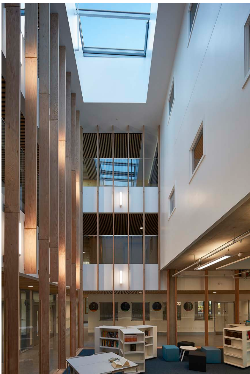
Tageslicht-halle, mit einem LAMILUX PR60 Glasdach Passivhaus überdachte Sitz- und Lernecke in der koedukativen weiterführenden Harris Academy in London
