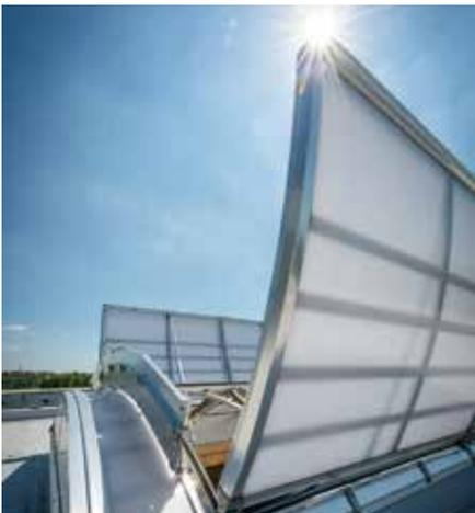
miteinander kombiniert werden. Der Vorteil: Die RWA-Klappen werden ideal abgestimmt auf die gewünschte Rauchabzugsfläche in die Lichtbänder integriert.
