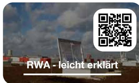
Wussten Sie, dass nicht das Feuer die größte Gefahr eines Brandes ist, sondern der Rauch? Deshalb sind Rauch- und Wärmeabzugsanlagen (RWA) im Brandfall echte Lebensretter. Sie führen Rauch sowie Gase schnellstmöglich ab und bilden eine rauchfreie Zone am Boden, die es ermöglicht sich selbstständig in Sicherheit zu bringen. Es gibt eine Fülle an verschiedenen RWA-Arten sowie Richtlinien, die es zu beachten gibt. Wir zeigen Ihnen alles Wichtige rund ums Thema RWA auf einen Blick.
