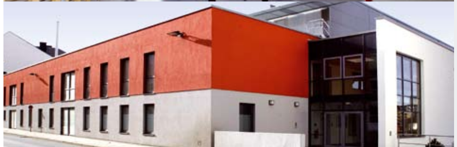
Objekt: Rudolf-Lion-Halle, Hof/Saale
